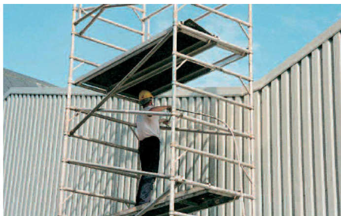
Overschildering van gevelbekleding
