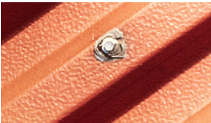
Beschadigde bevestiging
