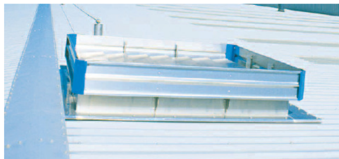
Een doorvoeropening in een dak
