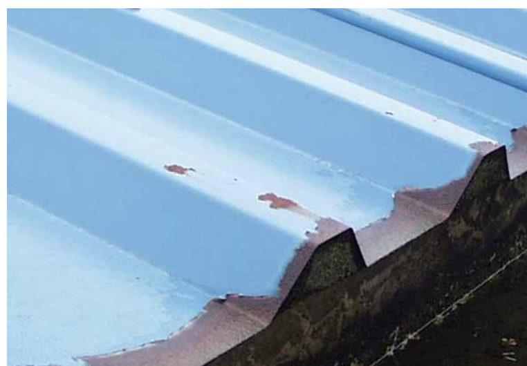
8.13 'Edge peel' met de eerste aanzetten van zogeheten 'rode roest'.
