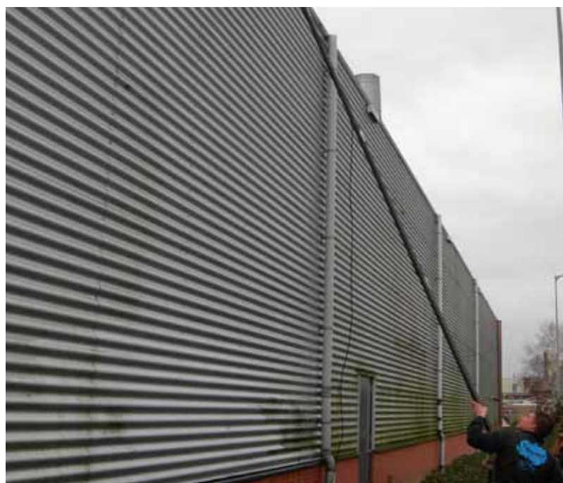
8.6 Het reinigingsmiddel wordt in principe van onder naar boven op een gevel aangebracht. De gevel wordt vervolgens van boven naar beneden afgespoeld.
