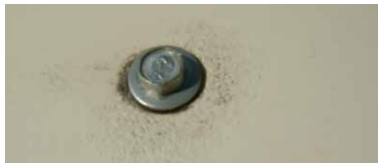
8.11 Blaasvorming rondom een bevestigingsmiddel. Gevels en daken moeten tijdens regulier onderhoud worden gecontroleerd op aantastingen en schaden. Gevoelige plekken verdienen extra aandacht. Het verhelpen of repareren van zwakke plekken is in een vroeg stadium geen kostbare zaak. Ook de eventuele eerste aanzetten van corrosie zijn dan tegen lage kosten te verhelpen.
