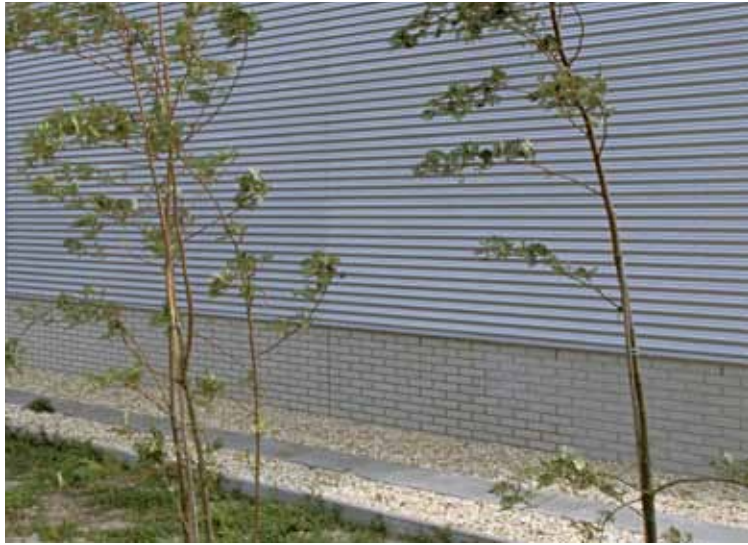
8.2 Een grindbed voorkomt het opsplatten van regenwater en vuil tegen de gevel.
