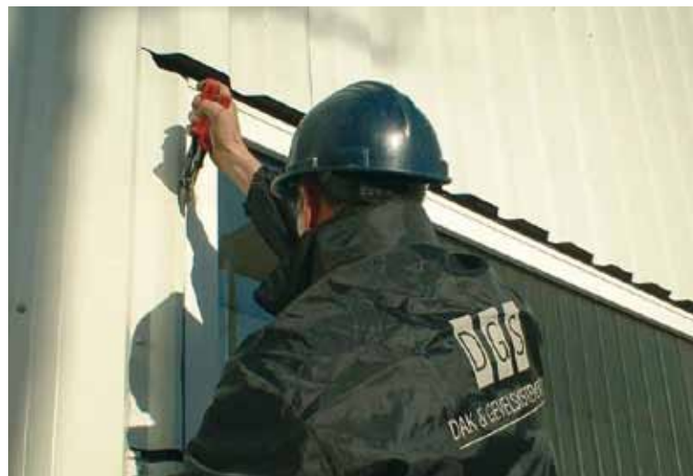
7.3 Inkorten op de bouwplaats met een knabbelschaar.
