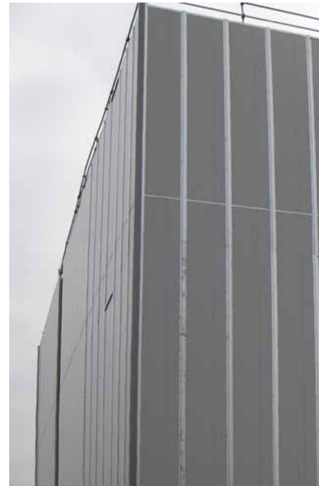
Project Merwetank met sandwichpanelen SAB-Carrier.
