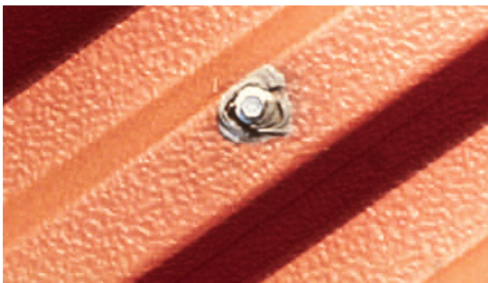
Beschadigde bevestiging
