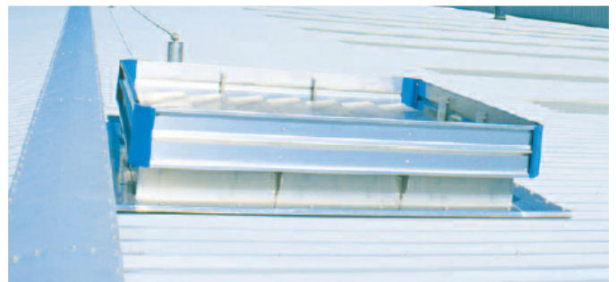
Een doorvoeropening in een dak
