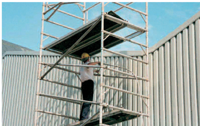
Overschildering van gevelbekleding
